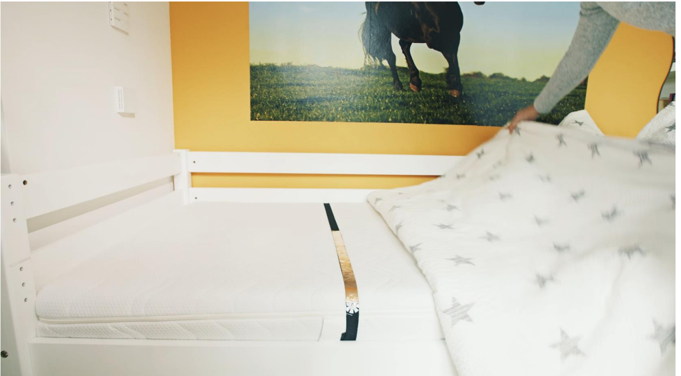
Abbildung 10: Feinfühliges Sensor unter Spannbetttuch zur Erkennung von Atmung und Bewegungskorrelaten, sowie KNX-VOC-Sensor an der Wand am Kopfende
